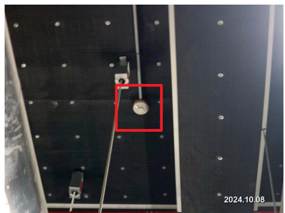
รูปที่ 3-32 เครื่องตรวจจับควัน (Smoke Detector) ภายในห้องเครื่องหม้อแปลงไฟฟ้าโครงการ
