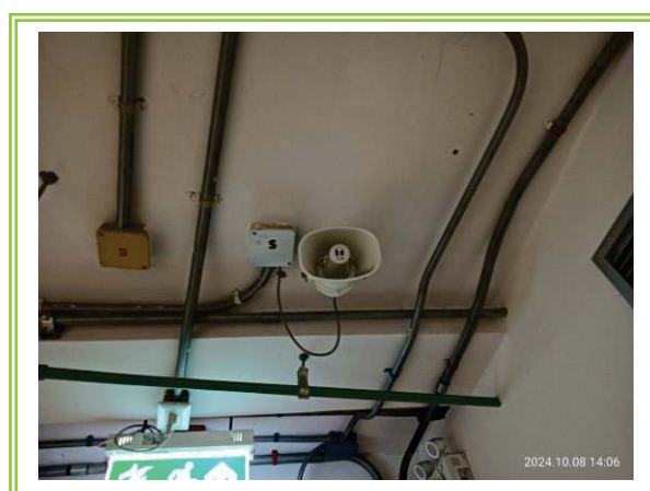
รูปที่ 3-49 ลำโพงแจ้งสัญญาณเตือนอัคคีภัย (Fire Alarm Speaker)
