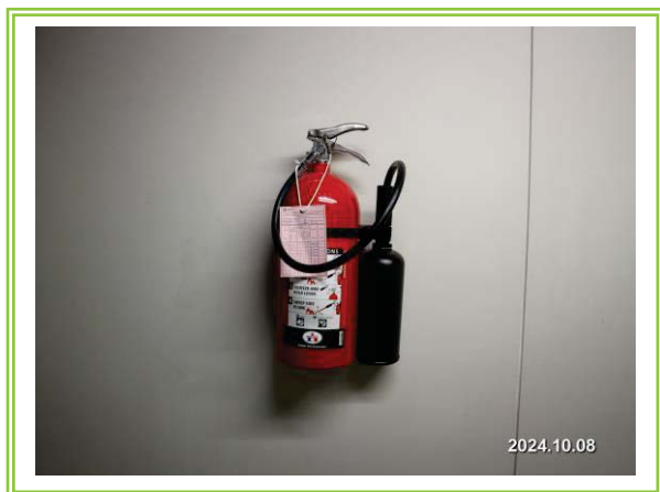
รูปที่ 3-44 ถังดับเพลิงเคมีแบบมือถือ
