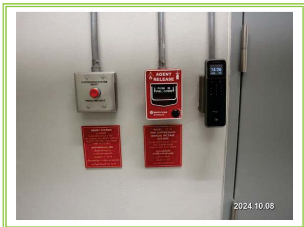
รูปที่ 3-50 เครื่องแจ้งเหตุด้วยมือผู้ใช้ (Manual Pull Station)
